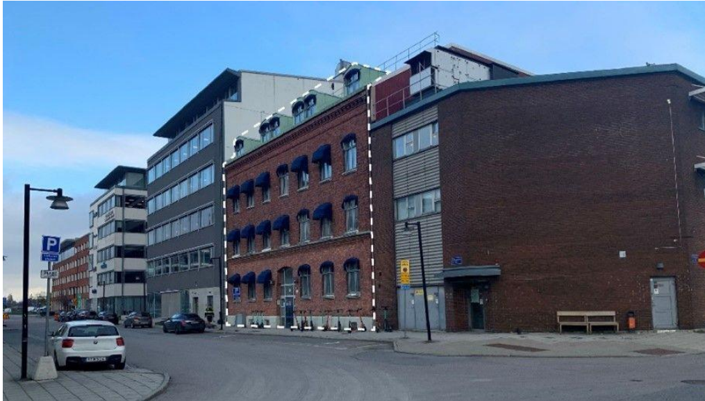
Figur 4: Foto visar planområdets sydvästra sida. Byggnaden inom Kilsgatan 10 som bevaras i detaljplanen markeras med streckad vit linje.
